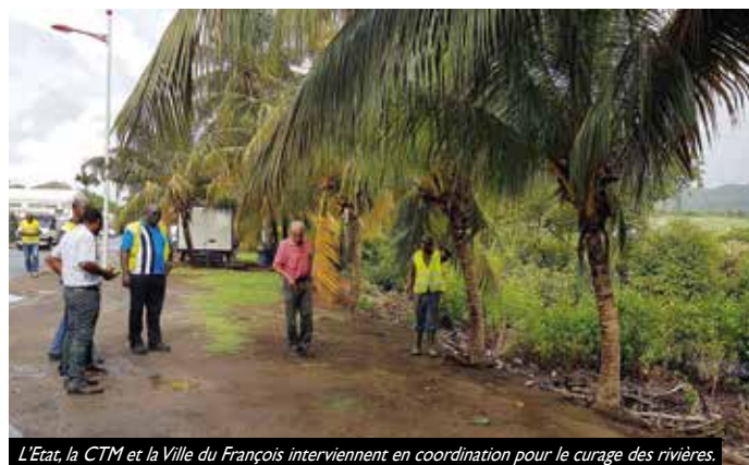
L'Etat, la CTM et la Ville du François interviennent en coordination pour le curage des rivières.
