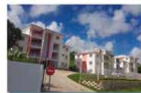
Résidence Les Ramiers
