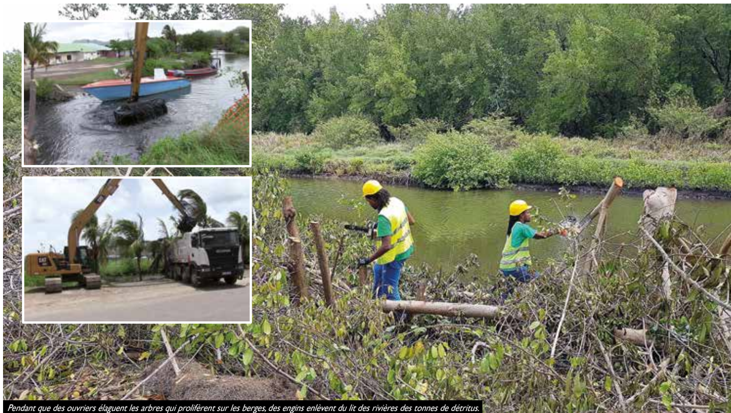
Pendant que des ouvriers élaguent les arbres qui prolifèrent sur les berges, des engins enlèvent du lit des rivières des tonnes de détritus.
